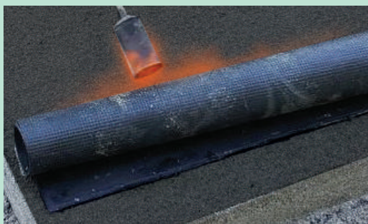
Saldataura guaina bituminosa su primer
