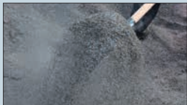
Sistemi G DRY SYSTEM e G DRY FAST Posa sottofondo a secco G MIX GRANULAR
