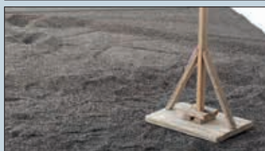
Sistema G DRY SYSTEM Posa massetto a secco G PLASTER FIBER
