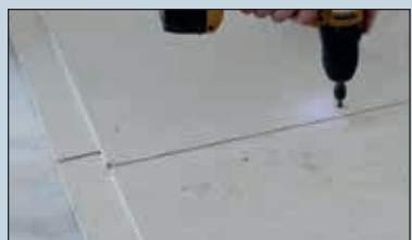
Sistema G DRY FAST Posa massetto cementizio
