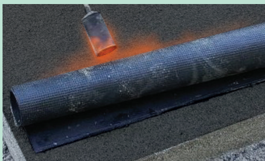
Saldatura guaina bituminosa su primer
