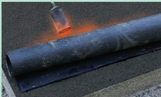
Saldatarea guaina bituminosa su primer
