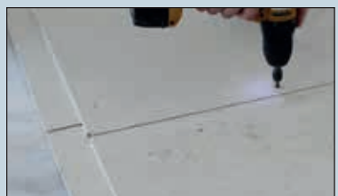
Sistema G DRY FAST Posa massetto cementizio
