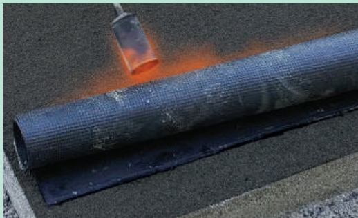
Saldatura guaina bituminosa su primer
