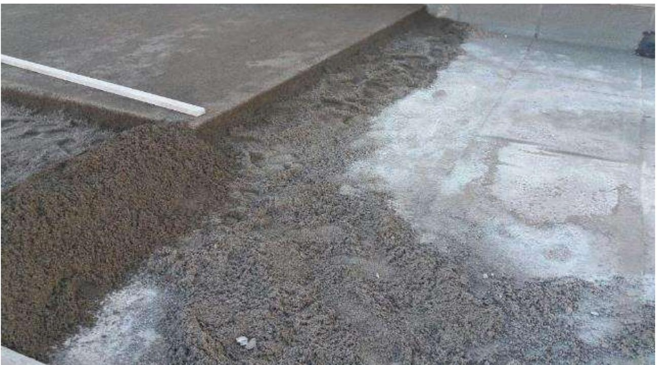
Ristrutturazione con isolamento termo-acustico di **1.750 mq** di copertura, in completa sostituzione dell'isolante leggero tradizionale, **senza smantellamento e smaltimento della vecchia impermeabilizzazione, con notevole risparmio dei costi di intervento e dei costi di esercizio per il riscaldamento invernale degli ambienti sottostanti**
