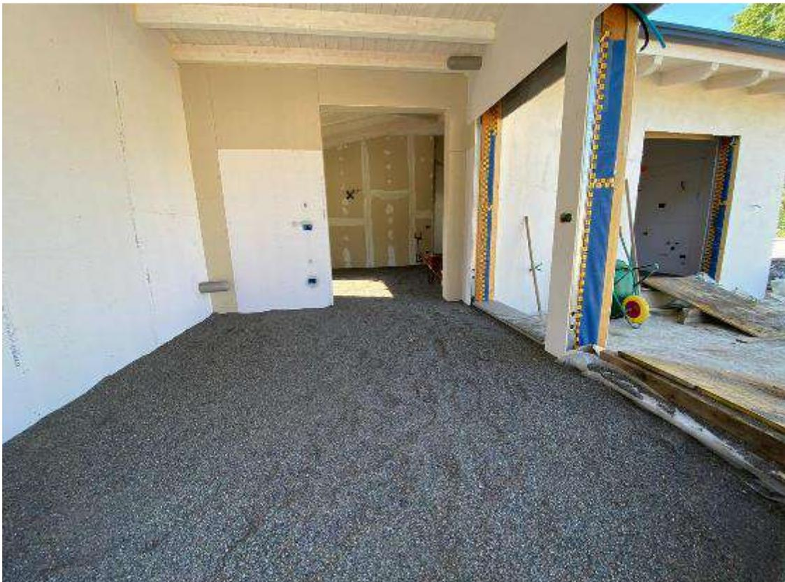
Isolamento termo-acustico di 300 mq di sottofondi interni con spessore 12 cm
