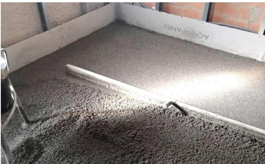
**Isolamento termo-acustico di terrazzi e coperture in completa sostituzione dell'isolante leggero tradizionale**
