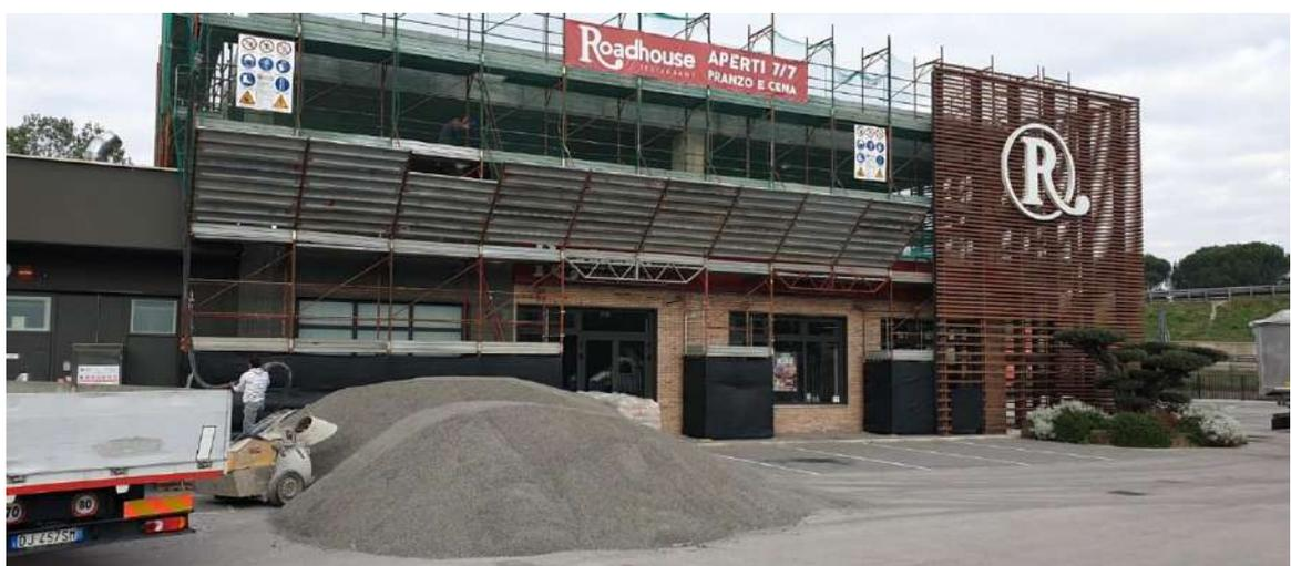
Isolamento termo-acustico di oltre **1.000 mq** tra coperture e sottofondi interni con spessore fino a 21 cm in **completa sostituzione dell'isolante leggero tradizionale**
